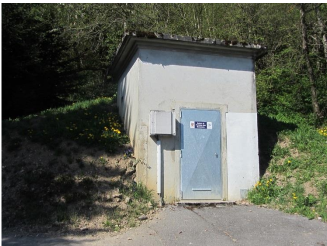
Station de pompage des Bossonnets
